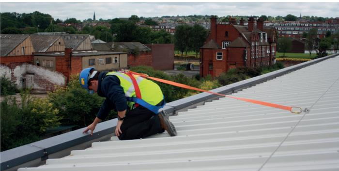
Dispositif de retenue : Pas de risque de chute
