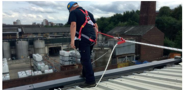
Dispositif d'arrêt de chute : chute potentielle
