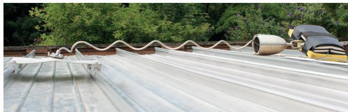
Sur toiture type Joint Debout aluminium bulbe
