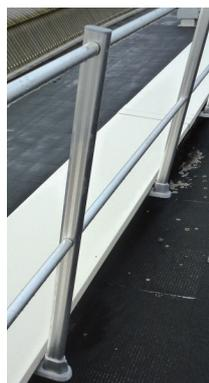
Fixation du garde corps sur l'acrotère grâce au Sabot Z. Son déport permet de se fixer sous la couvertine et préserve ainsi l'étanchéité de la terrasse.
